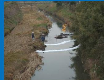
回収ポイントを後免した油膜を吹流し吸着材でバックアップ
