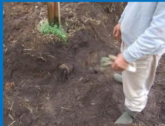
原因となった破断された埋設配管
