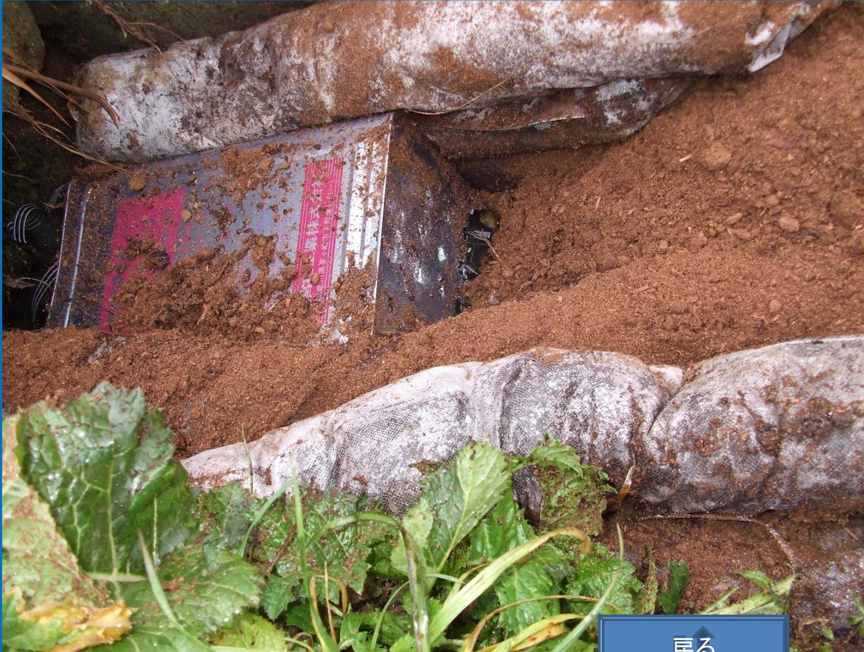
暗渠からの流出部に黒曜石パーライトとピートモスを利用して簡易ろ過槽を設置
