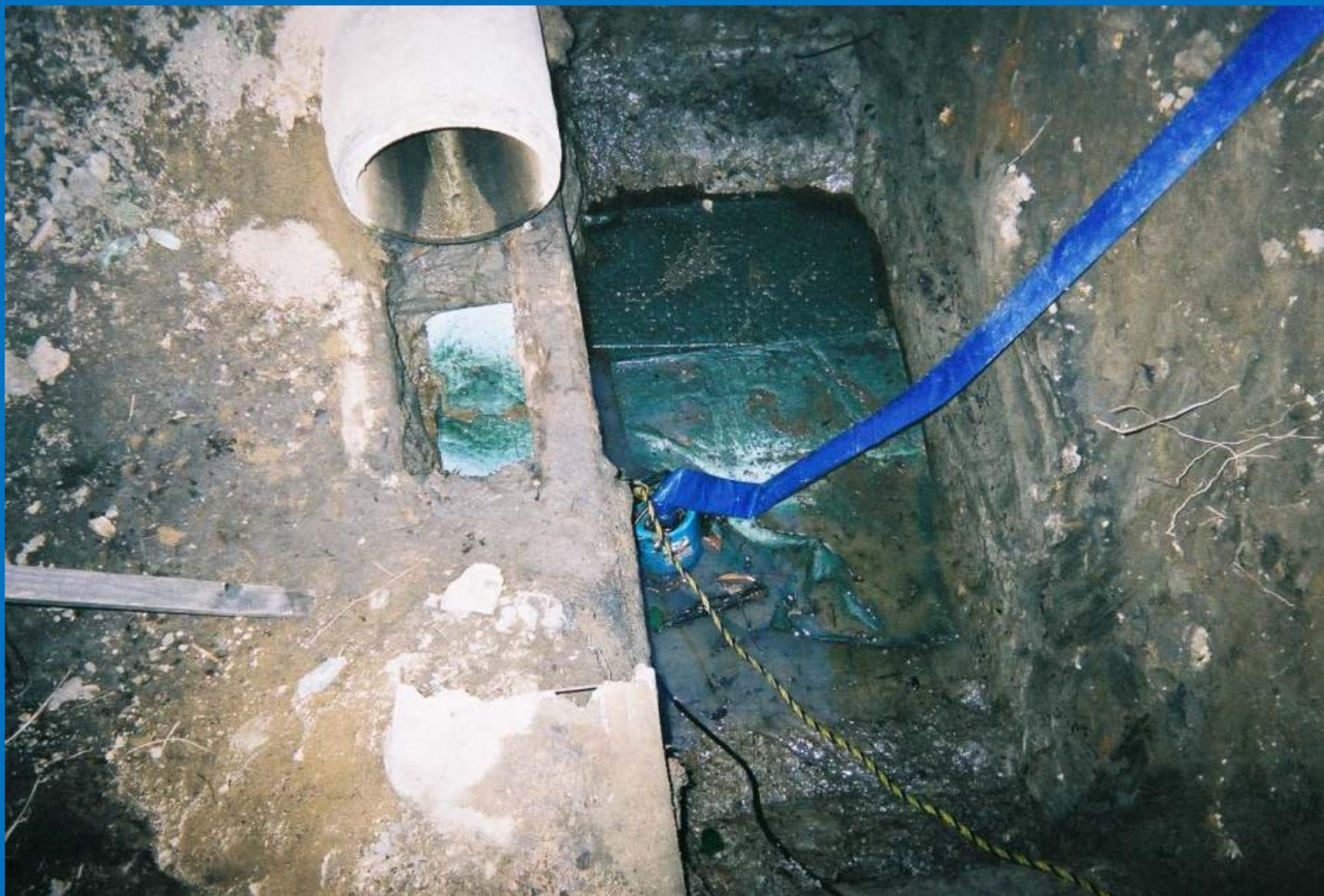
原因土壌を掘削して回収ピットを設ける
