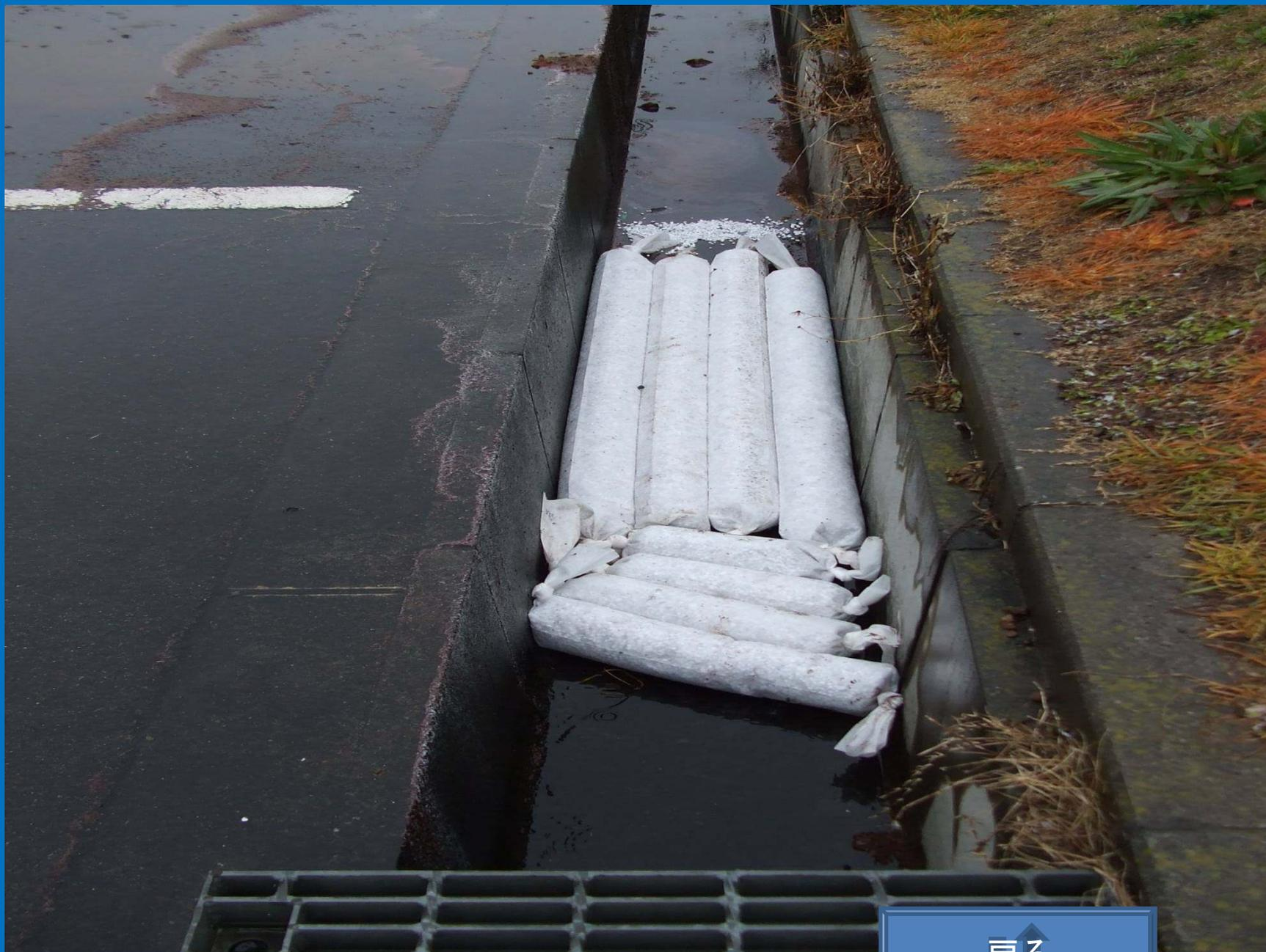
ターミナル内の側溝を油膜回収用の吸着材で養生し、外部への流出を防止
