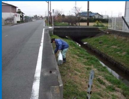
用水路への油膜流出を防ぐために、吸着用ピートモスを路肩に散布
