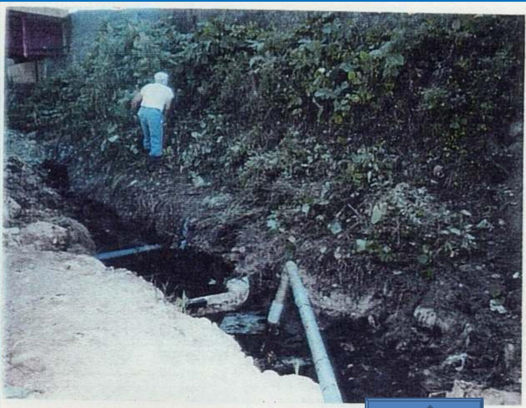
汚染土壌と本川の間掘削した回収用ピット
