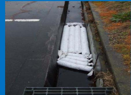
ターミナル内の側溝を油膜回収用の吸着材で養生し、外部流出防止
