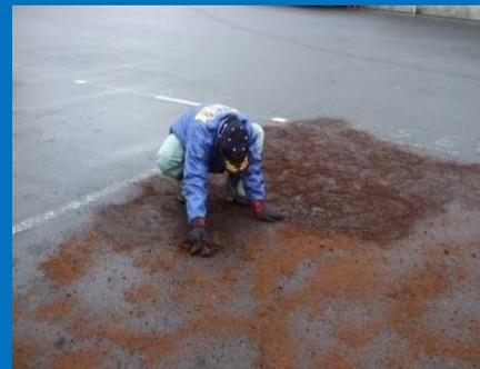
ターミナル内で初期処理をしたスペースに油痕が多く残り、吸着用ピートモスを散布して拭き取り作業
