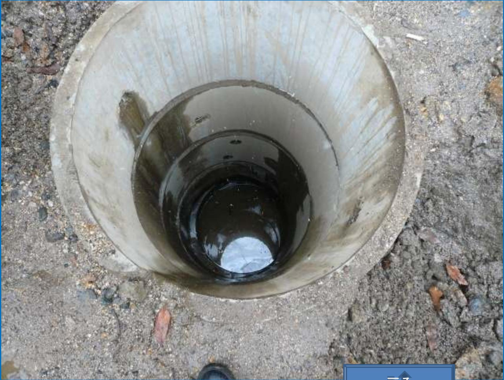
回収井戸を掘削してポンプで吸い上げ
